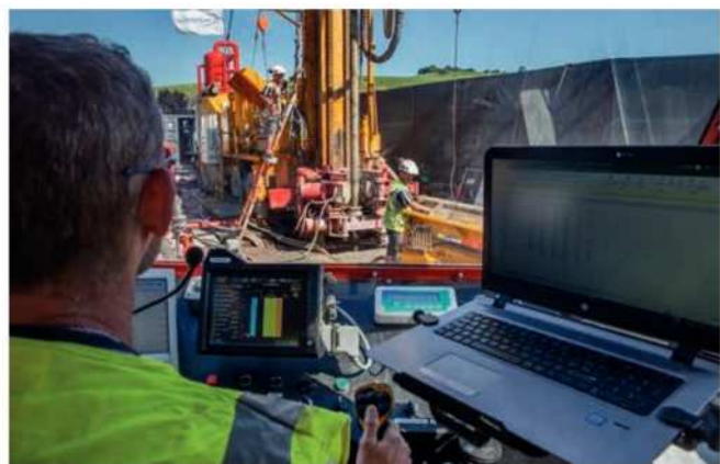
Après 8 mois de travaux, ce forage est descendu à une profondeur de 1456 m.
